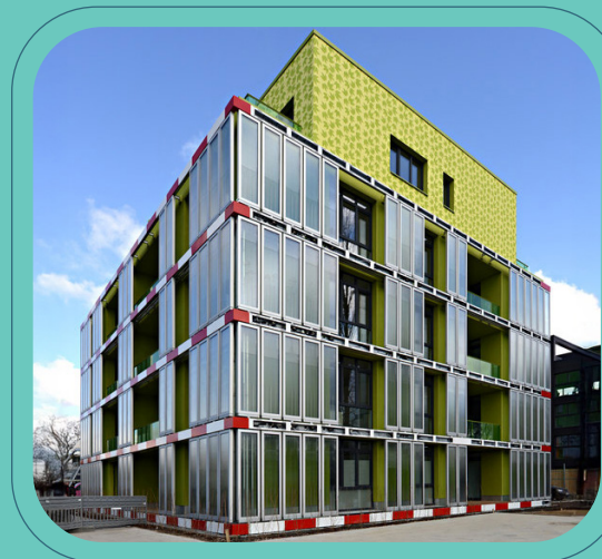
BIQ House (Splitterwerk, 2013) © Colt International, Arup Deutschland, SSC GmbH
